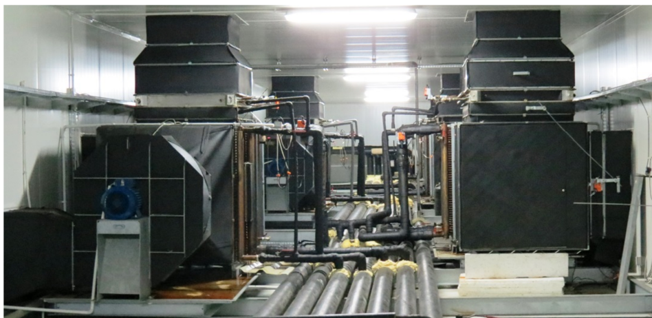
Rys. 1.3 Bloki klimatyzacyjne przygotowujące powietrze do czterech osobnych hal uprawowych
