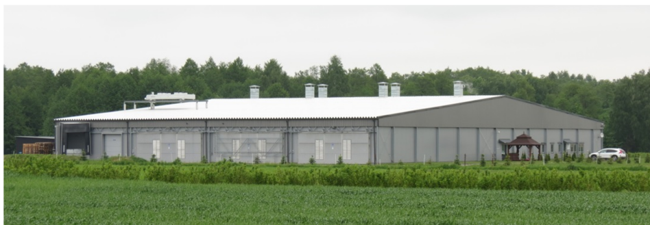
Rys. 3.1 Budynek pieczarekarni A1
