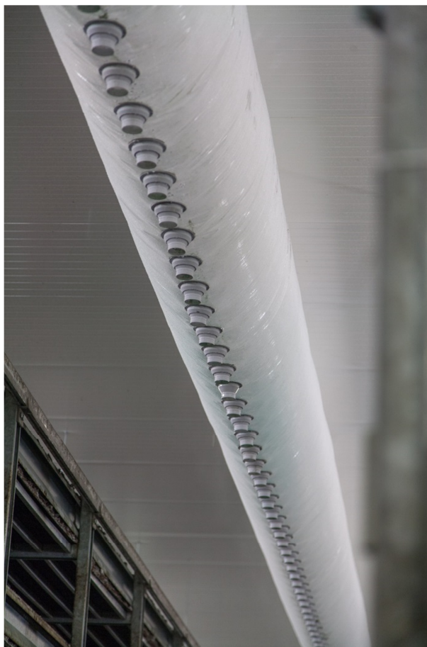
Rys. 1.5 Rękaw nawiewowy zawieszony pod sufitem hali uprawowej
